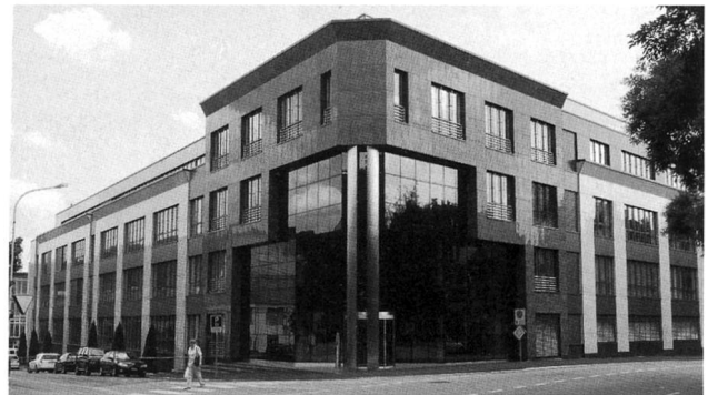
Das neue Bürogebäude «Belchen» der SIS Group
