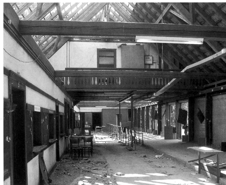
Das Innere des Schützenhauses in Olten während dem Abbruch
