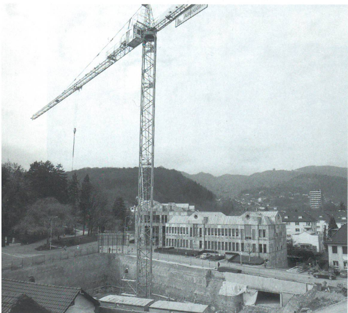
Der neue Bau wächst heran: von der Baugrube ...
