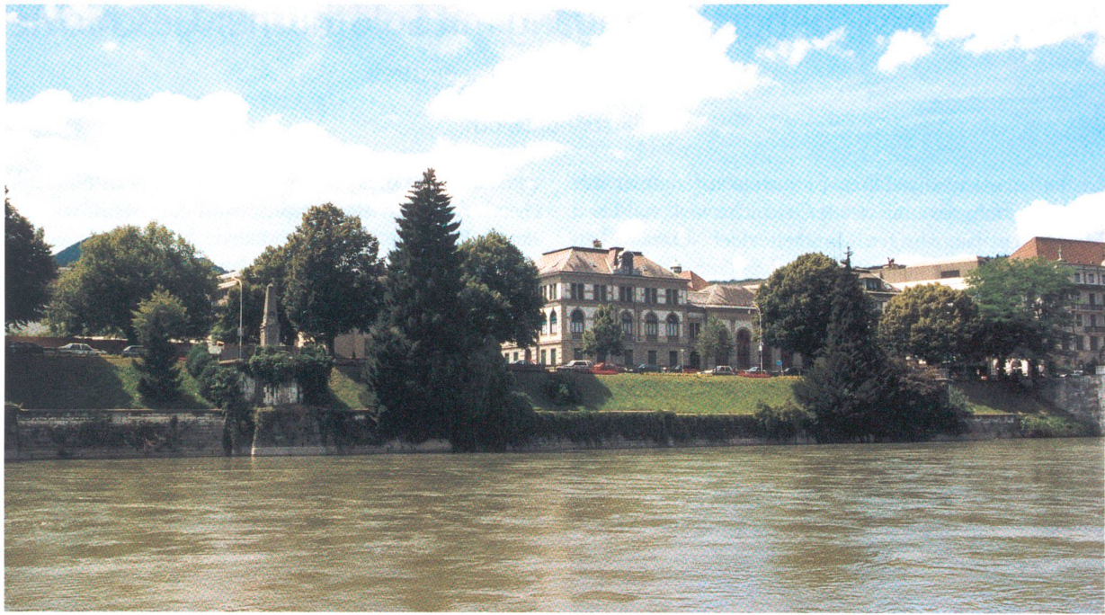
Amthausquai heute: Die ehrgeizige Anlage verschwindet zusehends unter einem dicken Kleid aus Bäumen, Büschen, Ranken und Moos.
