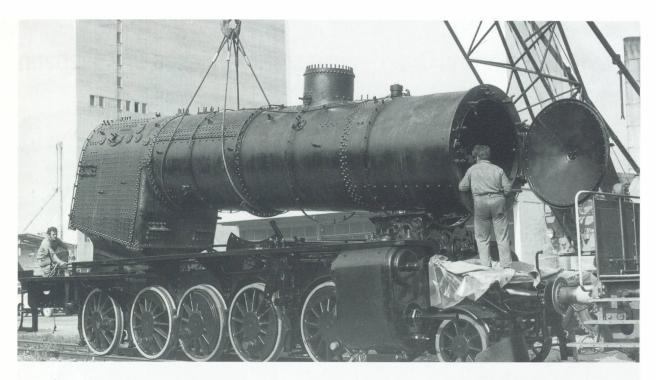
Aufsetzen des Kessels auf das Fahrgestell
