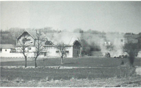
Oben: Hausruine in einer umkämpften Zone bei Podujevo und die Zerstörung ziviler Einrichtungen.
