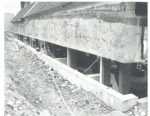
Die neue Mauer ist gegen Hochwasser durch einen soliden Blockwurf geschützt. Bald wird der Höherstau an die neue Mauer reichen. Wie die überflutete Ufervegetation das verkraftet, werden die kommenden Jahre zeigen.
