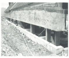
Die neue Mauer ist gegen Hochwasser durch einen soliden Blockwurf geschützt. Bald wird der Höherstau an die neue Mauer reichen. Wie die überflutete Ufervegetation das verkraftet, werden die kommenden Jahre zeigen.
