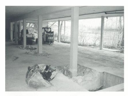
Blick in die ausgeräumte Bootshalle. Im Vordergrund gähnt der Schacht des Ruderrechens. Die Stirnwände sind bereits ausgebrochen. Eben ist die Längswand gegen die Aare gefallen. Die Betonpfähle werden stehen bleiben und Teil des «verlängerten» Fundaments werden.
