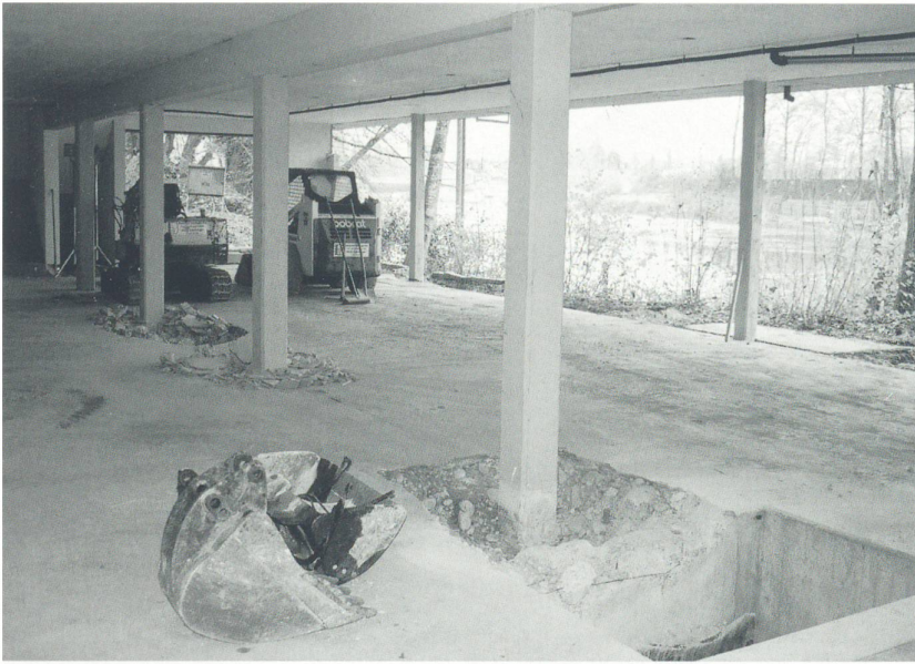
Blick in die ausgeräumte Bootshalle. Im Vordergrund gähnt der Schacht des Ruderrechs. Die Stirnwände sind bereits ausgebrochen. Eben ist die Längswand gegen die Aare gefallen. Die Betonpfähle werden stehen bleiben und Teil des «verlängerten» Fundaments werden.
