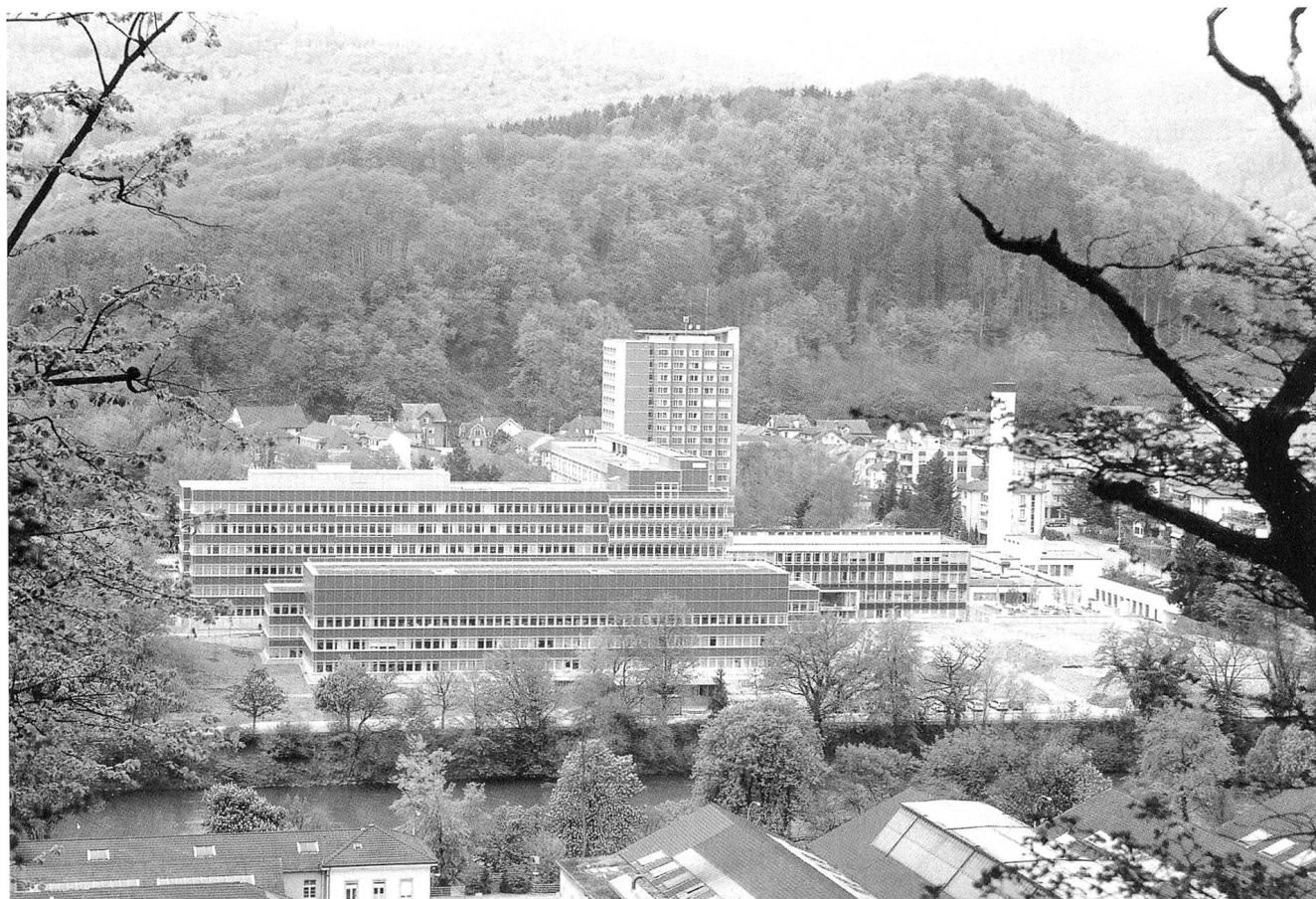
Sicht auf den Gebäudekomplex von der Aareseite her: im Vordergrund das «technische Gebäude», dahinter der neue Behandlungs- und Bettentrakt; im Hintergrund das renovierte Personalhaus
