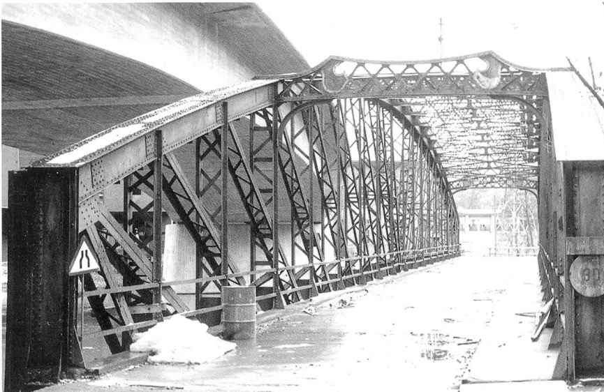
Unten: Die Brücke vor und während des Abbruchs 1965
