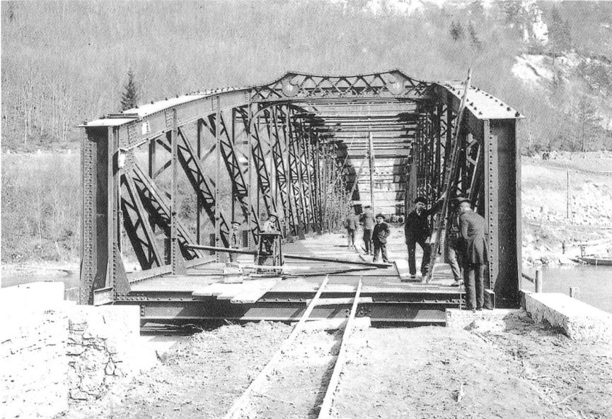
Oben: Fotografie von der Bauphase 1903
