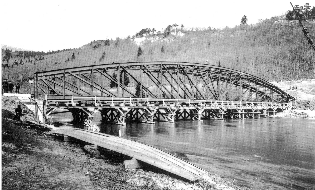
Die Rankwogbrücke im Bau. Fotografie von Karl Löhle im Frühjahr 1903.
