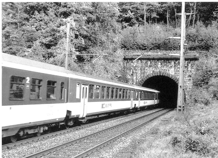
Das Südportal des Hauenstein-Basistunnels
