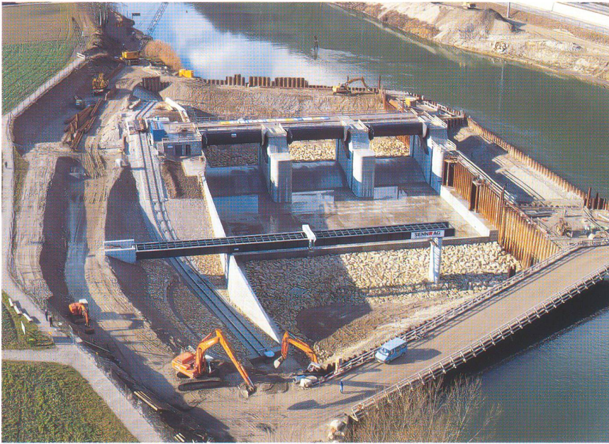
Noch im Trockenen: Das fertig erstellte Stauwehr im Januar 1998
