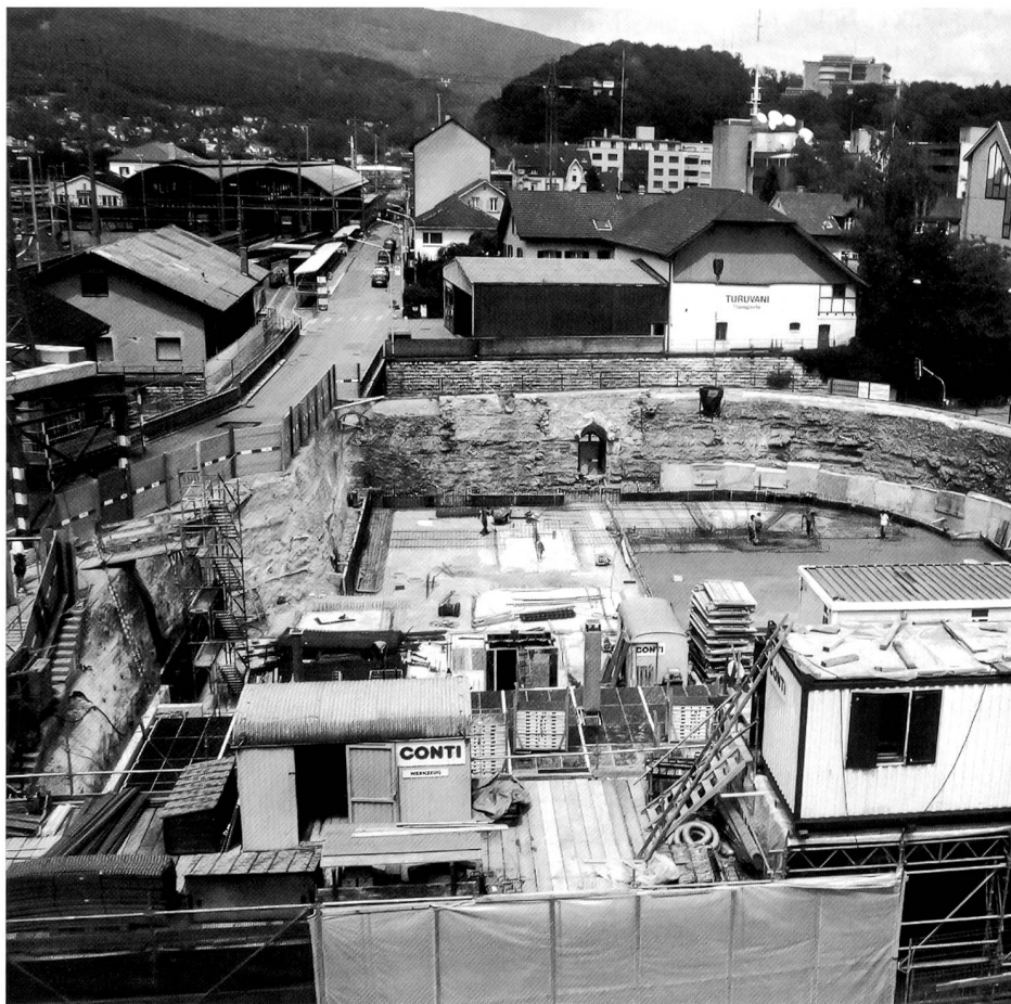
Das neue Geschäftshaus «Tannwald» ist im Entstehen.
