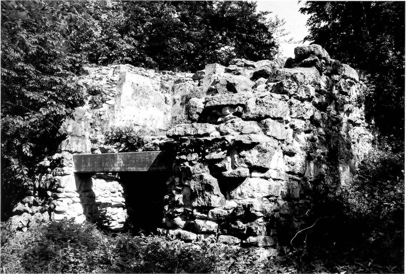
Heutiger Zustand der Ruine Obergösgen nach den Konservierungsarbeiten von 1987. Der untere Teil des Mauerwerks gehört zum Turmfundament, der obere ist der Rest einer Tankzisterne. – Der Wohnturm zählte wahrscheinlich zwei bis drei Stockwerke.
