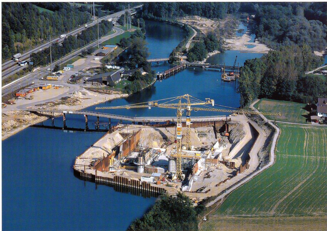
*Das neue Kraftwerk wird mitten in die Aare gebaut. Rund 300 Meter oberhalb des zum alten Kraftwerk gehörenden Stauwehrs entsteht im Schutze einer Baugrube das neue Wehr mit vier Öffnungen. Das Maschinenhaus wird in einer zweiten Etappe erstellt.*
