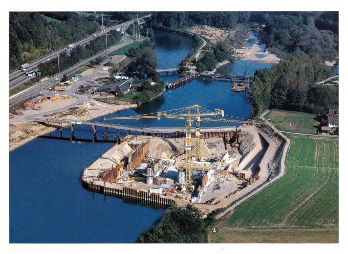
Das neue Kraftwerk wird mitten in die Aare gebaut. Rund 300 Meter oberhalb des zum alten Kraftwerk gehörenden Stauwehrs entsteht im Schutze einer Baugrube das neue Wehr mit vier Öffnungen. Das Maschinenhaus wird in einer zweiten Etappe erstellt.
