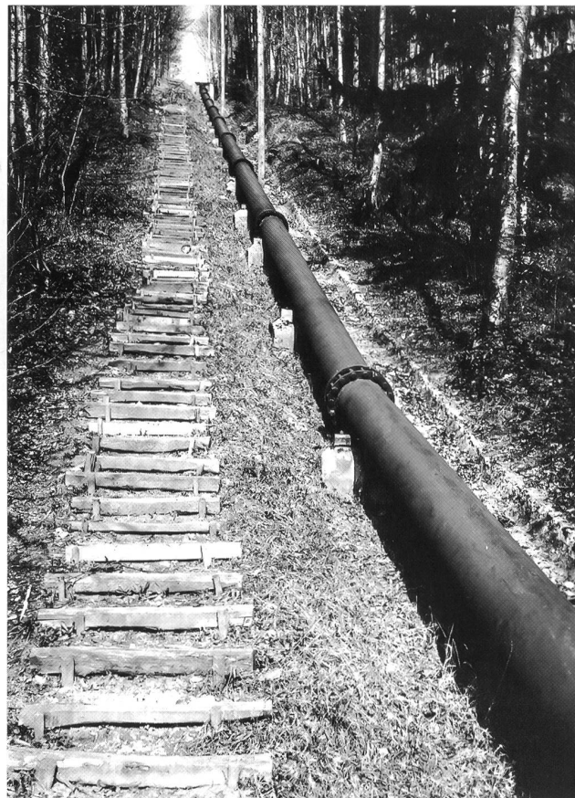
Druckleitung und Tuusigerstägeli (Abbruch Druckleitung 1960)
