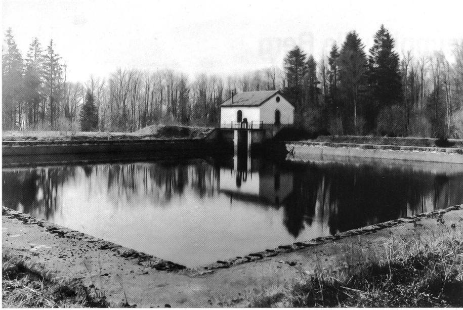
Speicherbecken mit Schieberhäuschen auf dem Born, 1904 realisiert, 1960 stillgelegt
