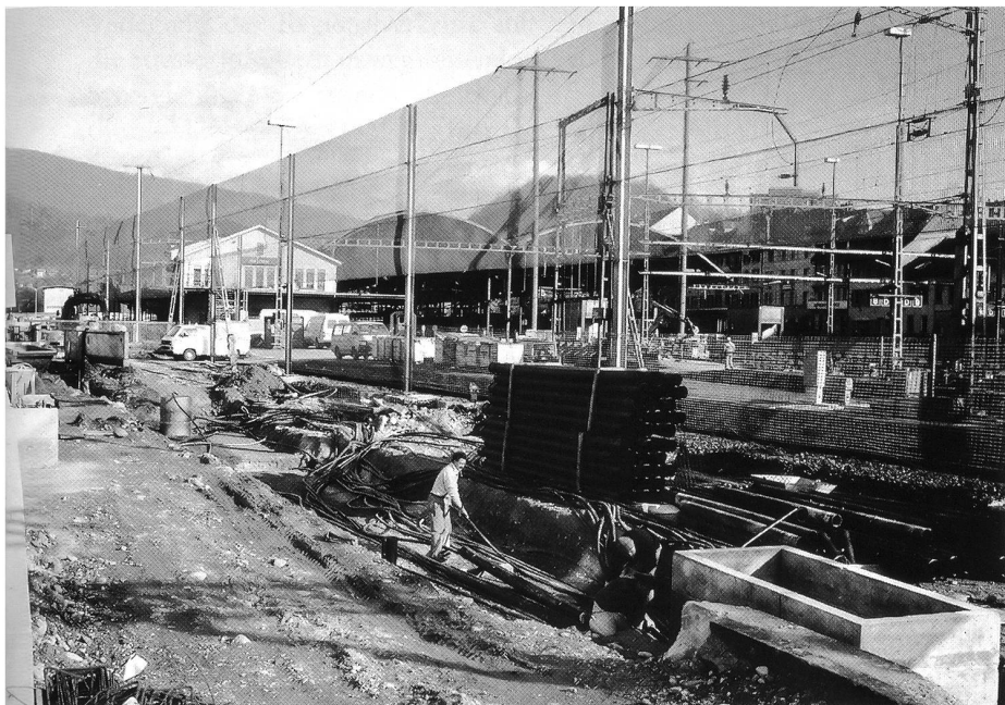
Neue Gleisanlage entlang der Bahnhofstrasse
