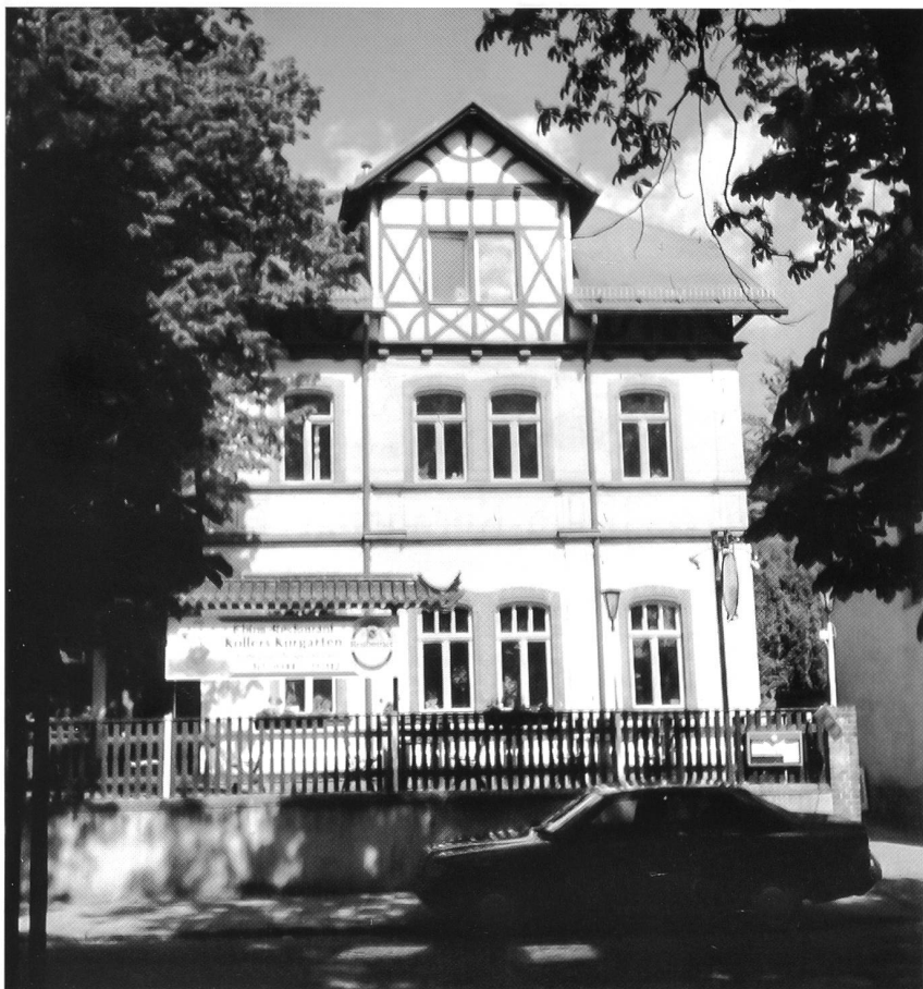
Kollers Kurgarten an der Bachstrasse 12
