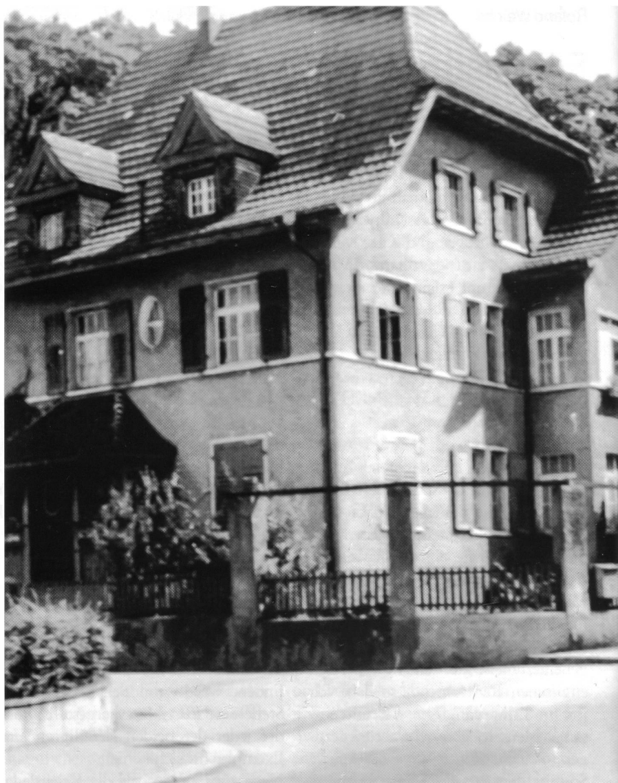
Villa Dr. Walter Richter an der Ecke Sonnbaldeustrasse/Martin-Disteli-Strasse Olten, heute ersetzt durch einen Wohnblock
