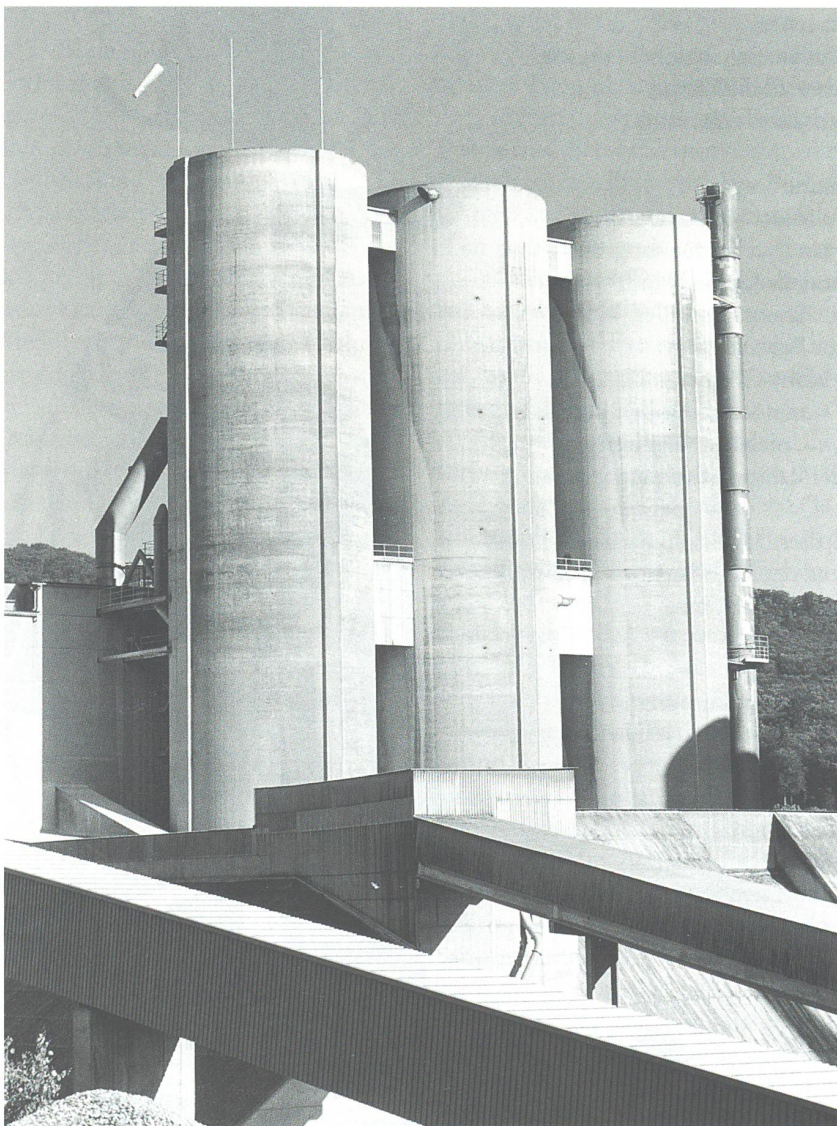
Einfache, prägnante Form moderner Technik in Sichtbeton: Silobauten der Oltner Portlandcementwerke
