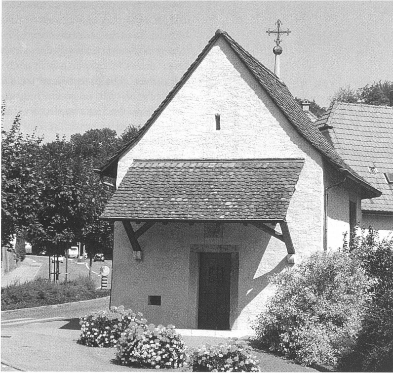
△ Ecce-Homo-Kapelle nach der Aussenrenovation 1989
