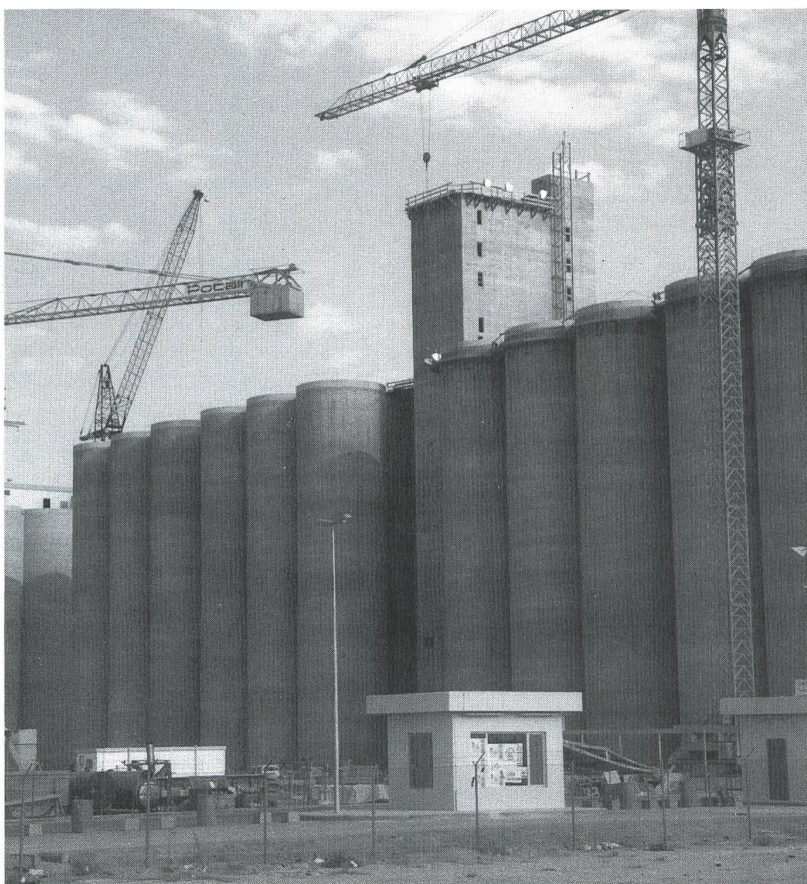
Getreideanlage Quosseem (Saudi-Arabien)
