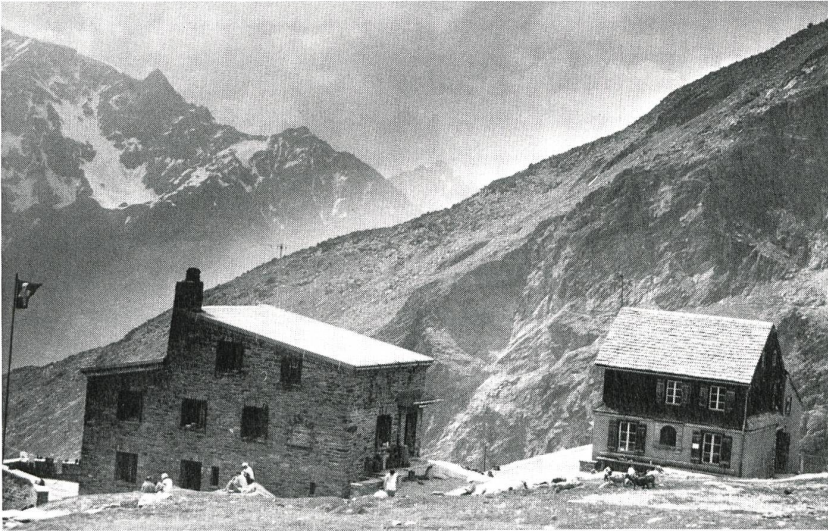
Die gute Lage am Fuss eines Viertausenders (Weissmies 4023 m) bedingte den Bau der neuen Hütte. Von den beiden Weissmieshütten bietet sich ein prächtiger Blick auf die Mischabelgruppe.
