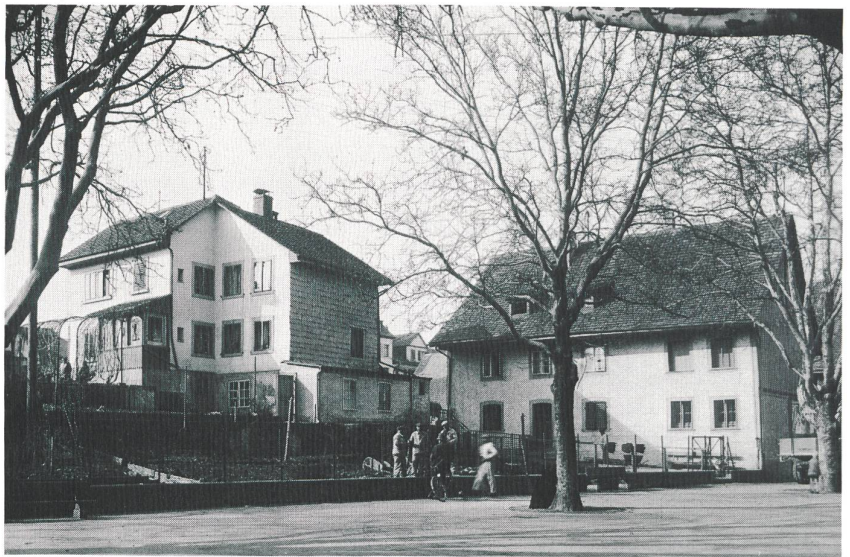
Mitte: Blick vom Munzingerplatz gegen das Hübeli. Im Vordergrund das Gebäude Nr. 191. Das Haus mit dem eigenartigen Winkel ist «Hans Flodertschis Haus» Nr. 188/189 (Foto Rubin).
