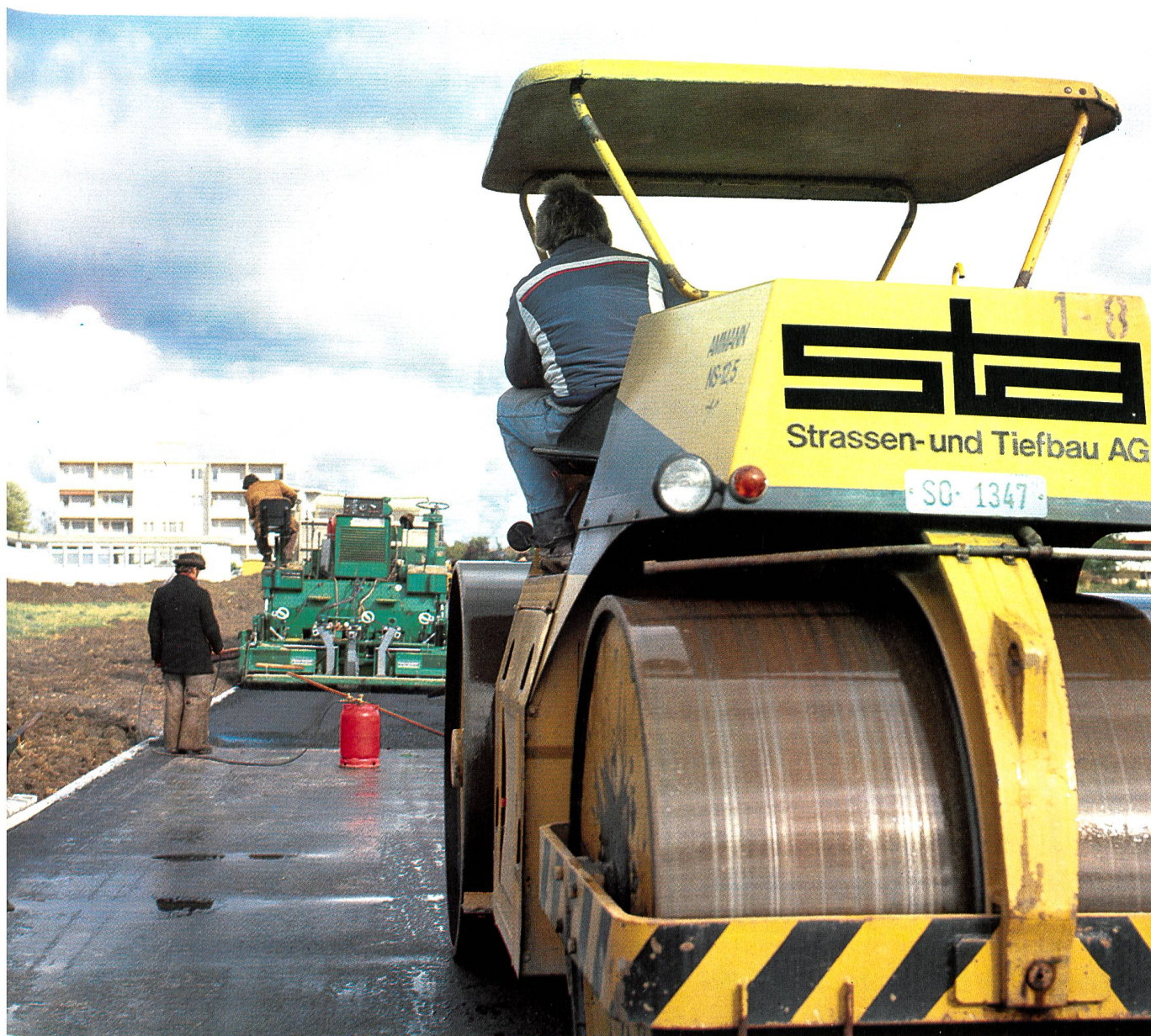
Einbau von Heissmischbelag auf einer Quartierstrasse in Kappel.
