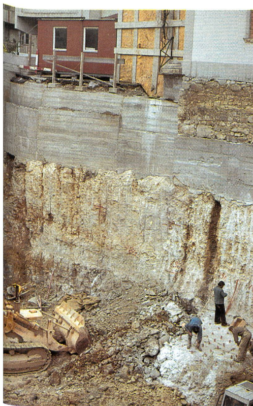
Felsaushub für Neubau in Olten.
