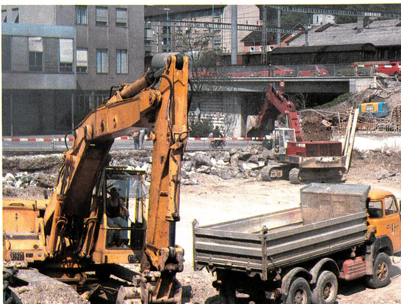
Aushubarbeiten, Überbauung Winkel, Olten.
