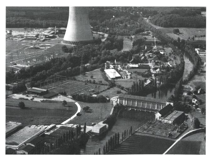
kV, 220 kV und 150 kV sind die Leitungen in jeder Spannungsebene über einzelne Sammelschienen miteinander verbunden. Die Spannungsebenen sind über Transformatoren zusammengekoppelt.
