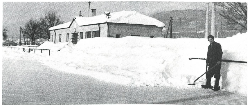
Die Kunsteisbahn Kleinholz Olten kurz vor der Vollendung. Links die Curlingbahn, rechts Eingang und Restaurant. ▼
