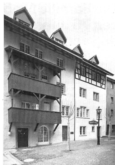
Fröschenweid nach Umbau 1978
