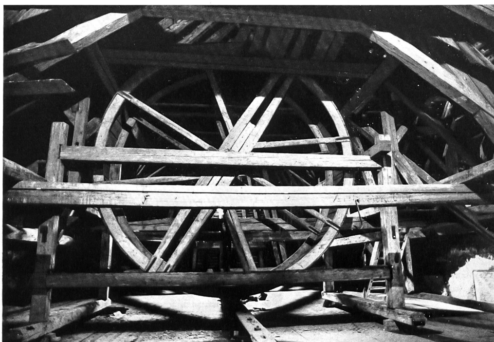
Tretwerk vom Kirchenbau 1806-1813 auf dem Dachboden der Stadtkirche. Foto Clemens Ackermann
