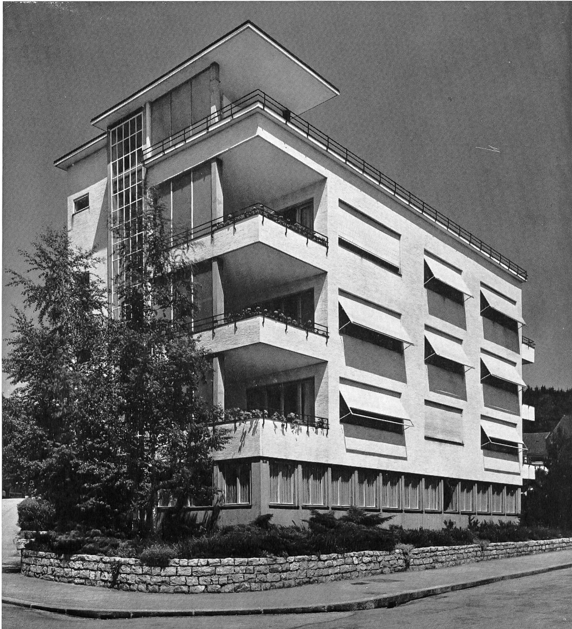
Frey und Schindler, Schweizerischer Samariterbund , 1938 Südwestseite. Verglaster Aufzugsschacht. Sichtbare Trennung zwischen Bürogeschoss und Wohngeschossen. Flachdach als Terrasse genutzt. Grosszügige Wohnbalkone.
