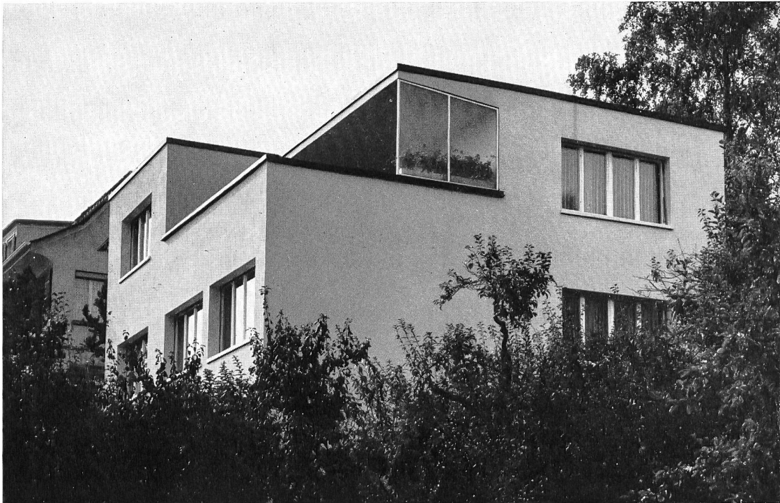
Richard Hächler, Einfamilienhaus Jurt in Trimbach , 1929 Kraftvolle kubische Gliederung des einfachen Baukörpers. Statisch begründete Dachschräge über Dachterrasse. Relativ grosse Fensterpartien mit verdeckten Rolladenkästen.
