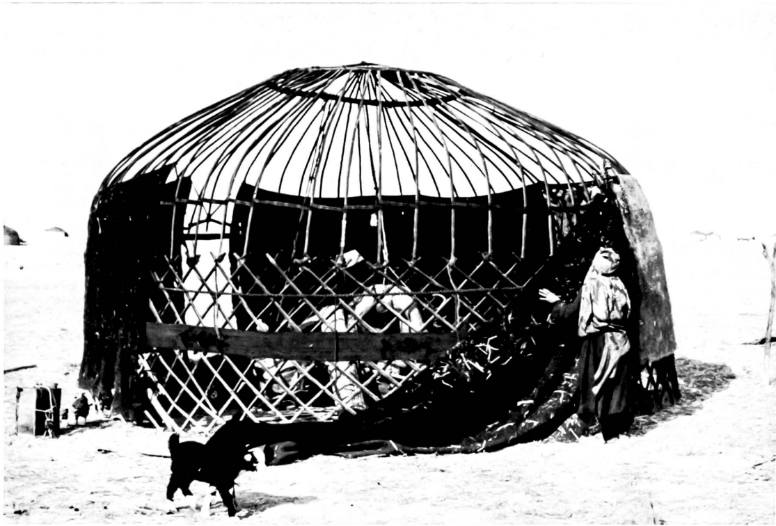
Konstruktion einer Jurte. Das Aufstellen ist Sache der Frauen und dauert ungefähr eine Stunde.
