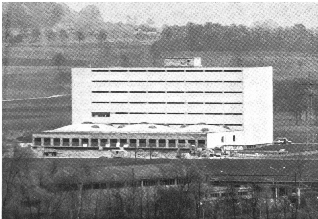
Das neuerstellte Lagerhaus in Gunzgen mit einer Lagerfläche von 15 000 m 2 . In den letzten Monaten wurden die Werkstätten und der Ablieferungsdienst ins Gäu verlegt.
