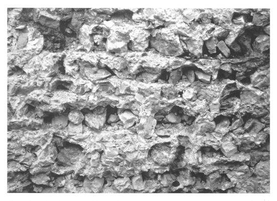
Olten, Klosterplatz Nr. 15. Beim Abbruch der Castrummauer zeigt sich im Querschnitt deutlich der lageweise Bau. Photo Ernst Müller.
