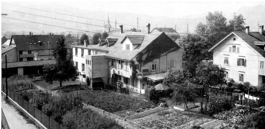
1920, Fabrik mit Wohnhaus, Ansicht Maulbeerweg
