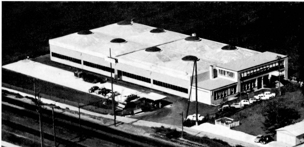
1966, Fabrikanlage in Hägendorf
