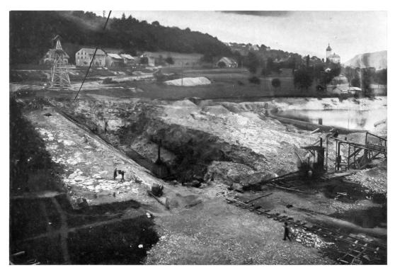
Aushub des Maschinenhauses in Gösgen (Löffelbagger mit Dampfantrieb).
