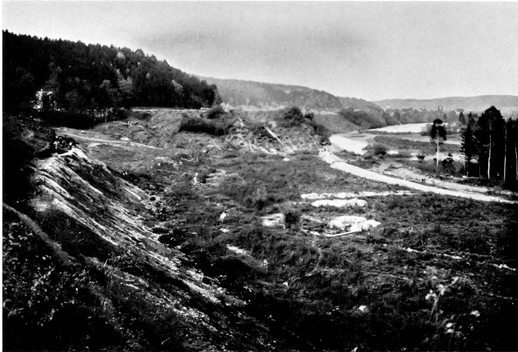
1914 Beginn der Kanalbauten bei der Ruine Gösgen (Bildmitte).
