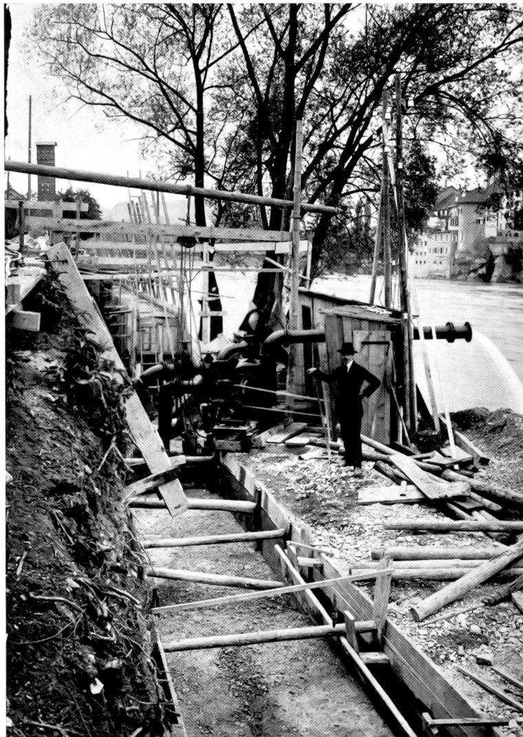
Verbauungen oberhalb der Bahnhofbrücke Olten, Blick auf das Schloss Zielempe.
