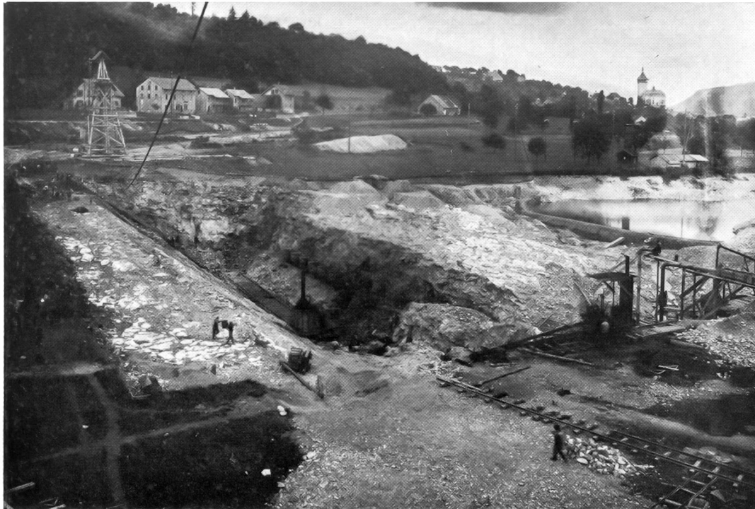
Aushub des Maschinenhauses in Gösgen (Löffelbagger mit Dampfantrieb).
