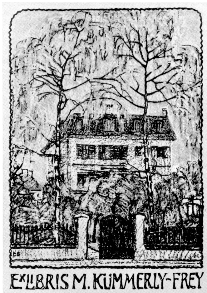
Das erste Gebäude der Kümmerly & Frey AG an der Hallauerstrasse in Bern
