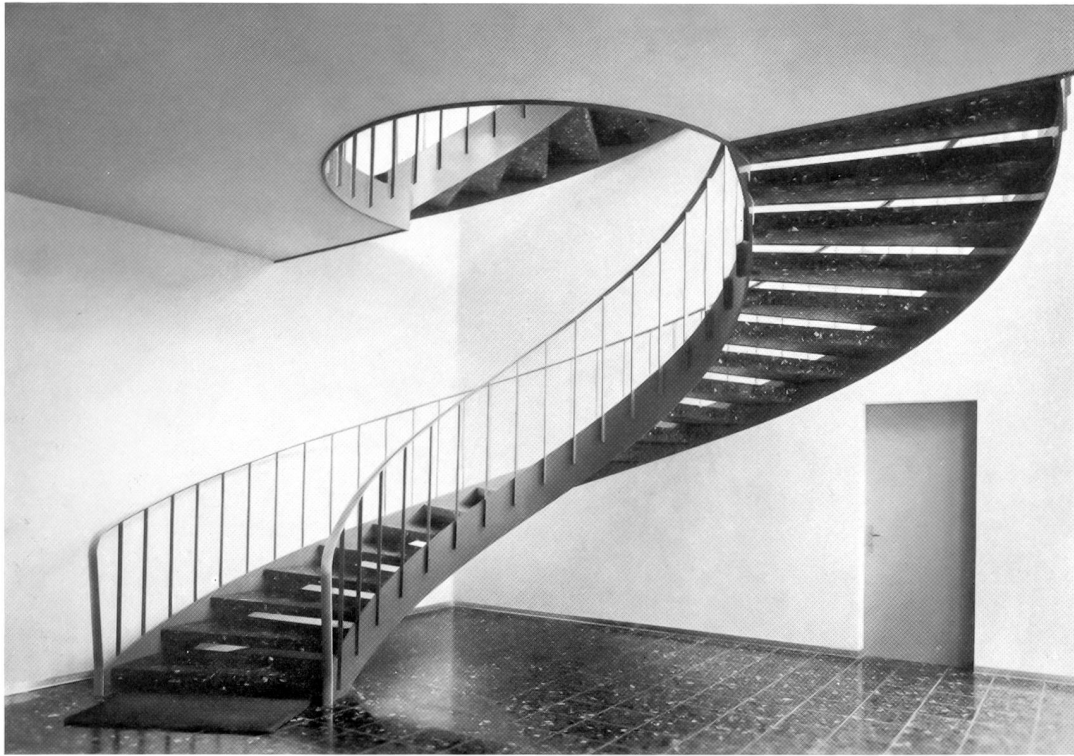
Gewundene Treppe mit Stahlwangen und geschliffenen Kunststeinritten durch 2 Stockwerke (Fabrik in Seon) Leichtmetallfront am Spitalbau (Olten)
