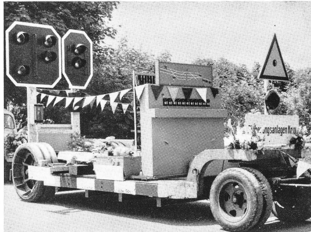
Elektrisches Stellwerk mit Ge- leisebild und Licht-Tagessignalen
