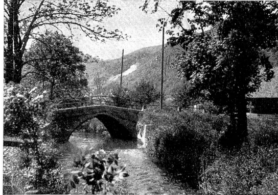
Abb. 4 Alte Straßenbrücke in Egerkingen.
