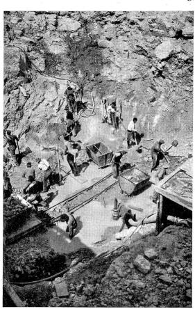
Abb. 20 Baugrube für den großen Absturz östlich des Stauwehrs der Filztuchfabrik. Aushub im obern Sequan.
