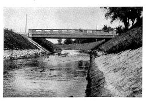
Abb. 6 Moderne Eisenbetonbrücke ersetzt die Straßenbrücke in Kappel.
