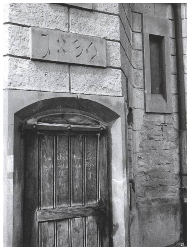
Schäden an der Schutzengelkirche: Abbröckelnder Verputz und Feuchtigkeitflecken.
