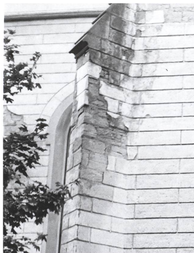
Schäden an der Schutzengelkirche: Abbröckelnder Verputz und Feuchtigkeitflecken.
