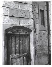
Schäden an der Schutzengelkirche: Abbröckelnder Verputz und Feuchtigkeitsflecken.
