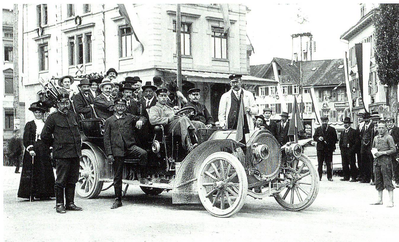
Das «Festtram», ein etwas grösseres Automobil, transportierte Gäste vom Bahnhof zum Festplatz im Niederdorf. Im Hintergrund das alte Gemeindehaus und die Buchhandlung und Papeterie Cavelti.
