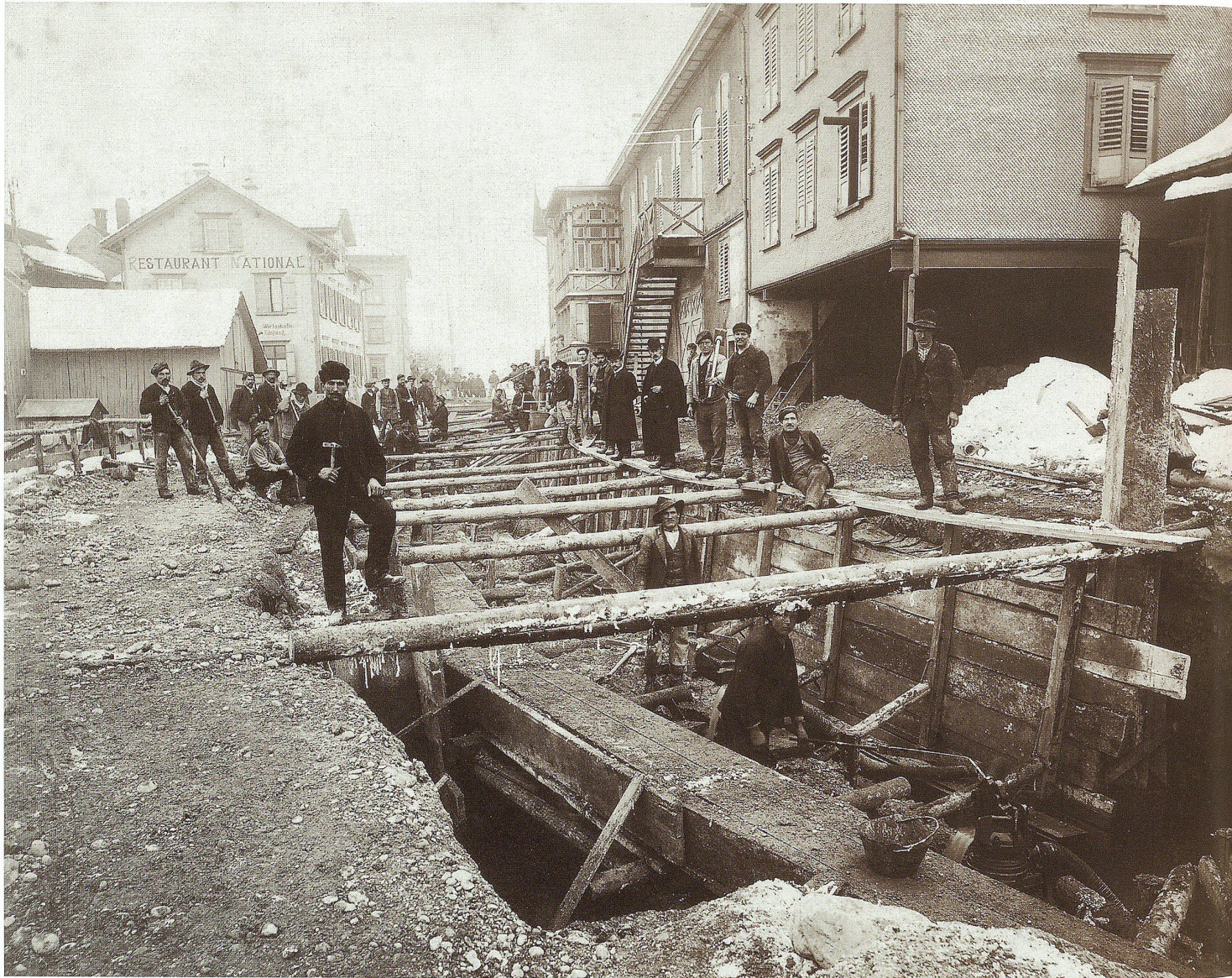
Italienische Arbeitskräfte bei der Dorfbachüberdeckung (1910) an der Ringstrasse. Aufnahmen dieser Art entstanden jeweils, wenn der Unternehmer und die Bauherrschaft die Baustelle besichtigten. Hier erkennt man zwei der «Herren» mit schwarzen Hüten und schwarzen Mänteln in der Bildmitte.
