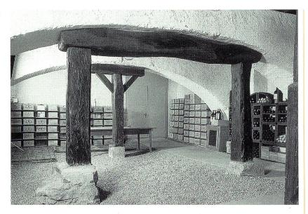
Kellergewölbe – einst Ablage für Transportgut. Die mächtigen Holzstützen nahmen das Gewicht der Stickmaschinen ab.
