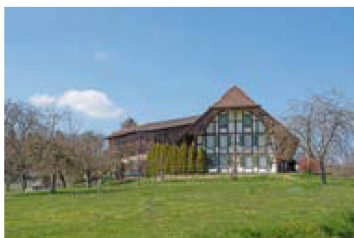
Moos. Bauernhaus von 1851. Einacher Riegbau mit geknicktem Ründidach. Gute topographische Situierung als oberer Abschluss der Streusiedlung Moos. Foto: Urs Ingold
