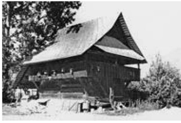
Speicher. Zürichstrasse 3b. Aus dem 17. Jahrhundert. Feingliedriger Bohlenständerbau mit einem charakteristischen Pultdach. Foto: Denkmalpflege
