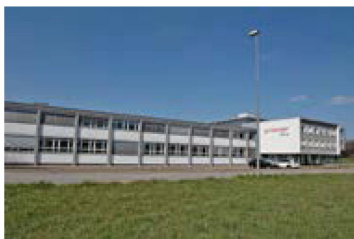
Möbelfabrik 1954. Kubische Eisenbetonkonstruktion des Zürcher Architekten Ernst Messerer. Foto: Urs Ingold
