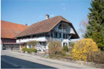
Stöckli 1816. Keller von 1738. Schmucker Riegbau mit einem leicht gekrümmten Ründidach. Um 1900 Einbau der Schaufensterfront eines Verkaufsladens. Bis 2006 über der Türe: F. Jenzer. Foto: Urs Ingold
