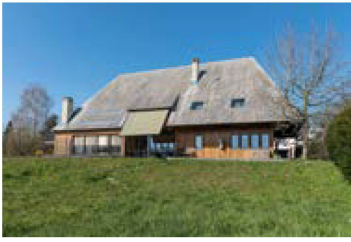
Restauriertes Taunerhaus aus dem 18. Jhd. Foto: Urs Ingold
