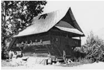
Speicher. Zürichstrasse 3b. Aus dem 17. Jahrhundert. Feingliedriger Bohlenständerbau mit einem charakteristischen Pultdach. Foto: Denkmalpflege
