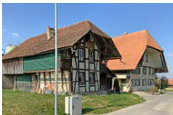
Rank. Rechts Bauernhaus von 1871. Renoviert um 1910. Riegbau mit grobem Wurfputz. Links Stöckli von 1807. Handwerklich sorgfältig gebautes Kleinstöckli mit holzsichtigem Rieg. Schützenswerter Bau. Foto: Simon Kuert
