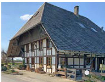
Nach dem Rank. Ehemaliges Doppelbauernhaus von 1810 (Jahrzahl auf der BÜGE). Gebaut von Johann Herzig. Besonders wohlproportionierter Riegbau mit Halbwalmdach. Foto: Simon Kuert
