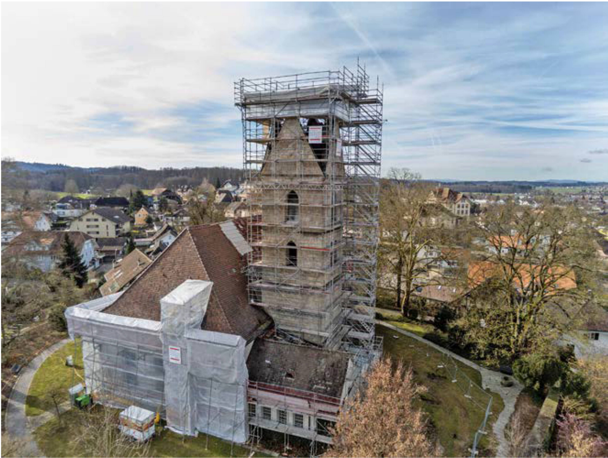
Die Kirche ist eingerüstet und hat ein Notdach erhalten. Foto: Michael Wüthrich, Kirchgemeinde Herzogenbuchsee
