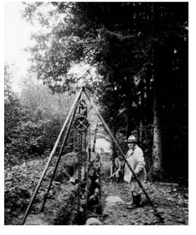
Die Transportleitung vom Madiswiler Quellwasser bis hinunter nach Langenthal funktionierte zwar mittels natürlichem Gefälle, war aber mit einem Durchmesser von bloss 300 Millimetern auf 3000 Liter pro Minute begrenzt. Da konnte das Reservoir auf dem Moosrain mit 1000 Kubikmetern Wasserinhalt noch so voll sein, der Engpass für die Wasserversorgung des auf mittlerweile 6200 Einwohnerinnen und Einwohner angewachsenen «Dorfs» Langenthal blieb bestehen.
