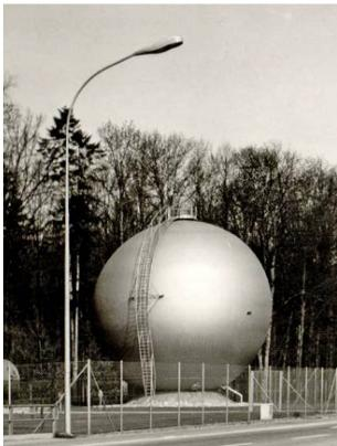
Mit dem Bau des Hochdruckkugelbehälters im Hard, der «Gaskugel», wurde 1972 von Fern- auf Erdgas umgestellt.
