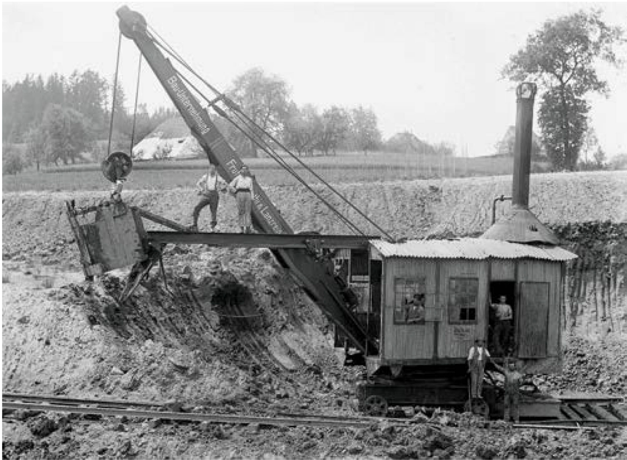
Der Dampfbagger kam bereits im Ersten Weltkrieg zum Einsatz. Foto: Johann Schär
