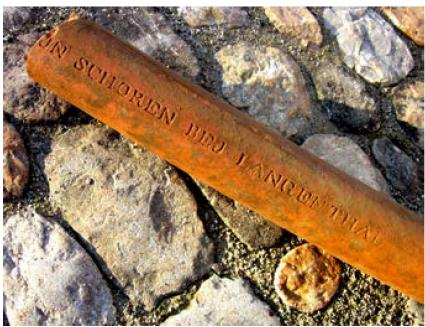
Die geborgene Reinigungsöffnung, auf den Kopf gedreht. Die Röhre ist durch die künstliche Öffnung nicht beschädigt worden. Selbst wenn es einen Riss gegeben hätte – die Ummauerung ist derart sorgfältig ausgeführt, dass die Dichtigkeit wohl trotzdem gegeben wäre.
