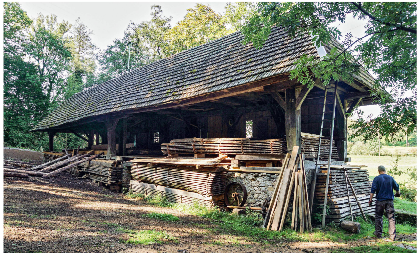
Abb. 4 Die Sagi im Önztäli. Nur auf der Rückseite besteht eine Wand. Dahinter befindet sich das Wasserrad. Foto H. Rentsch
