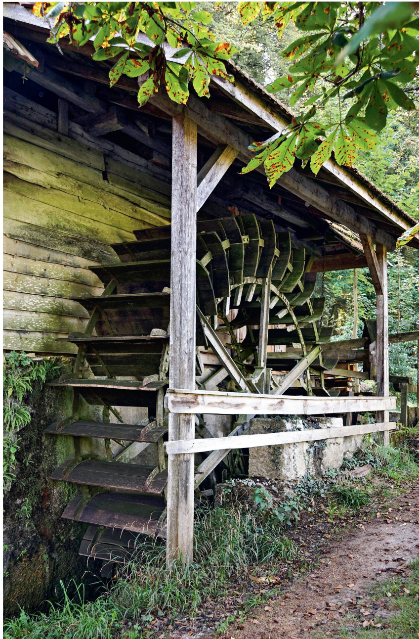
Abb. 8 Das Wasserrad des Ingenieurs Walter Zuppinger. Das Wasser fließt von rechts gegen unten aufs Rad. Foto H. Rentsch
