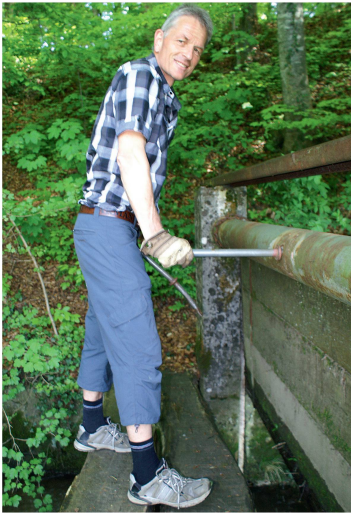
Abb. 5 Klaus Allemann hebt die Pritsche und öffnet damit den Wasserzufluss.
